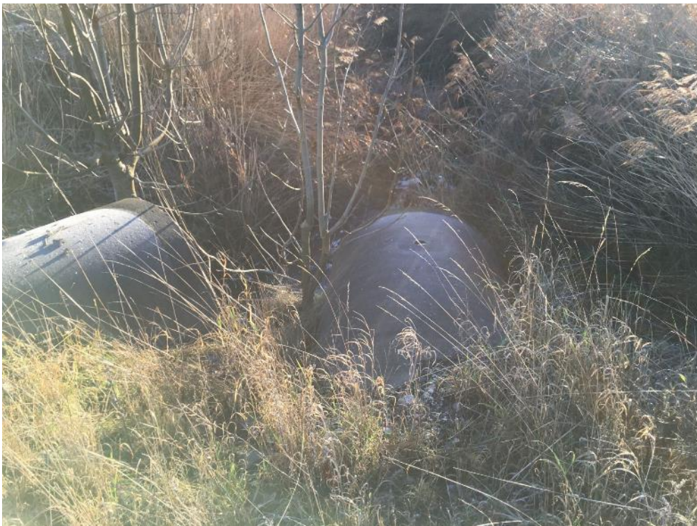
Figur 4. Bilden visar inloppet till kronriket som passerar genom planområdet. Fotot är taget från Ginnlögs väg söderut. I bild ses trumman som passerar under Ginnlögs väg från den lilla dikessnutten norr om vägen samt utloppet dagvattenledning från del av det tekniska avrinningsområdet. Trummorna är av samma dimension med en innerdiameter på 1000 mm.
