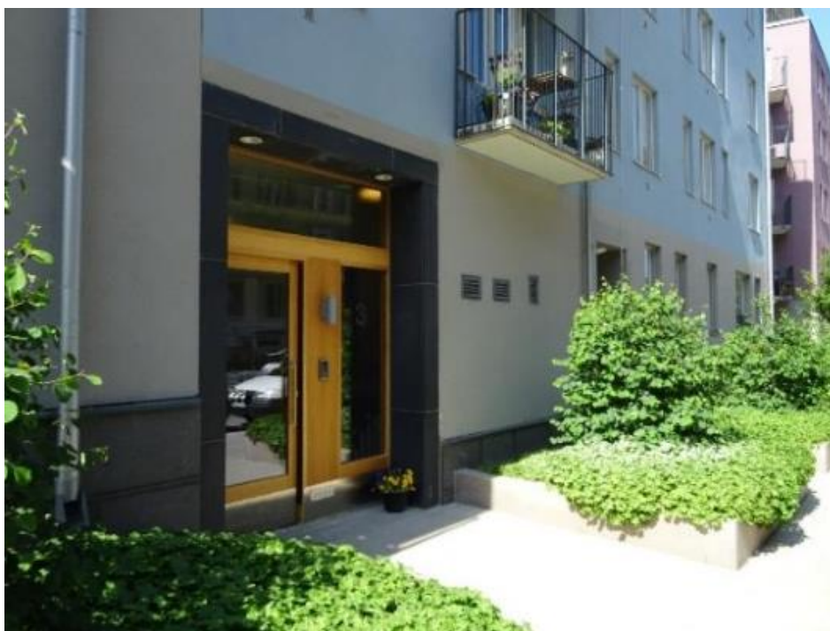
Figur 17. Exempel på regnbäddar för takvatten typ förgårdsmark, Stockholm. Foto: WRS.
