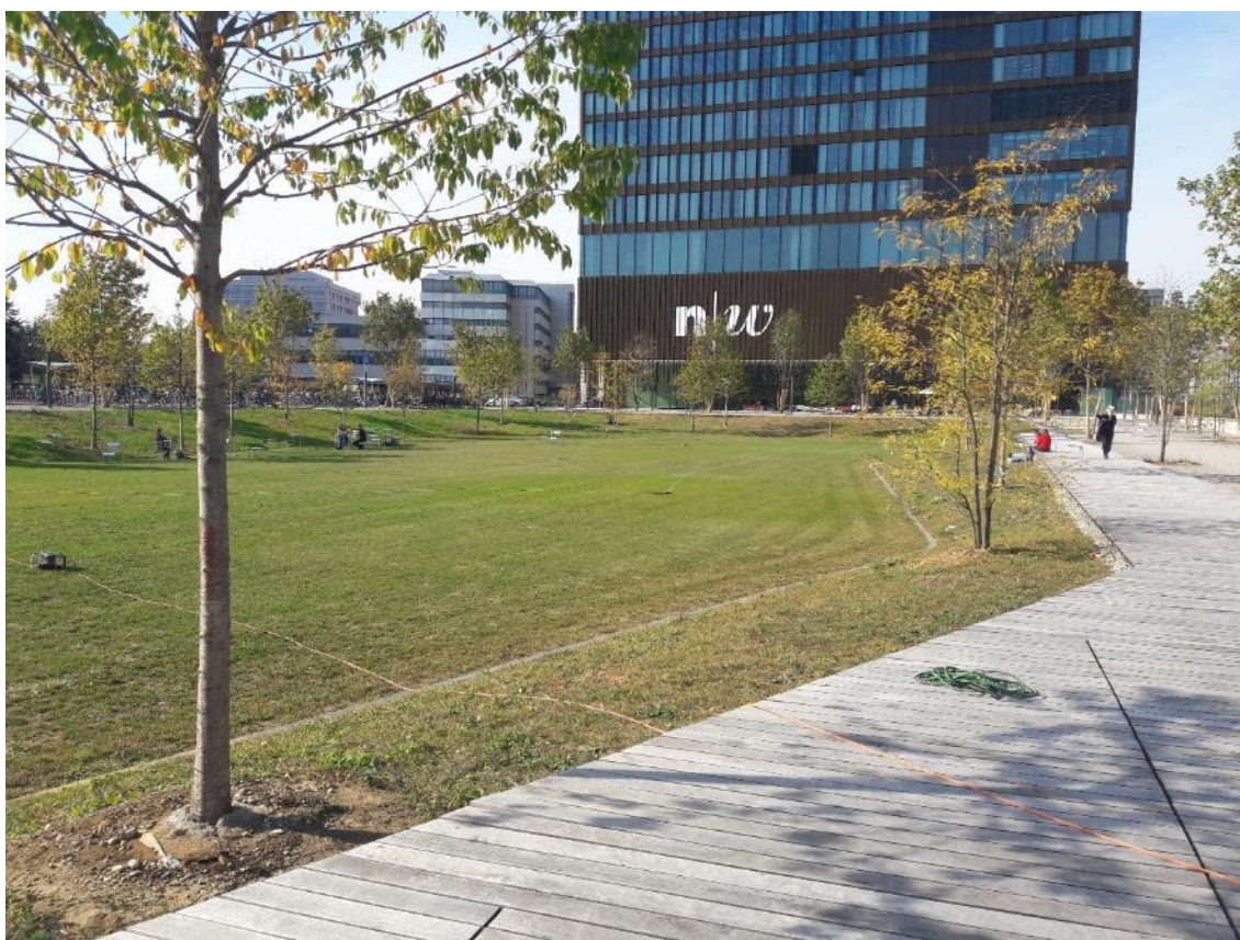
Figur 23. Exempel på nedsänkt grönyta som vid torrväder kan användas för boll-lek, event eller spontana aktiviteter men som vid nederbördstillfällen fungerar som utjämning och bidrar med rening. Foto: WRS.
