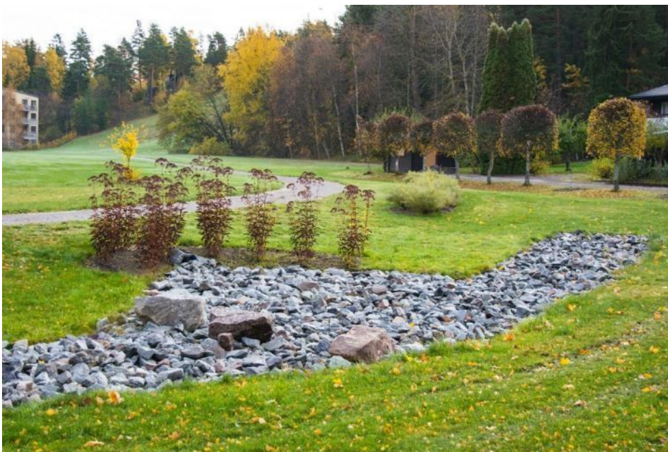
Figur 31. Exempel på utformning av yta som används för utjämning och viss rening av dagvatten vid större nederbördsevent, Täby. Foto: WRS.
