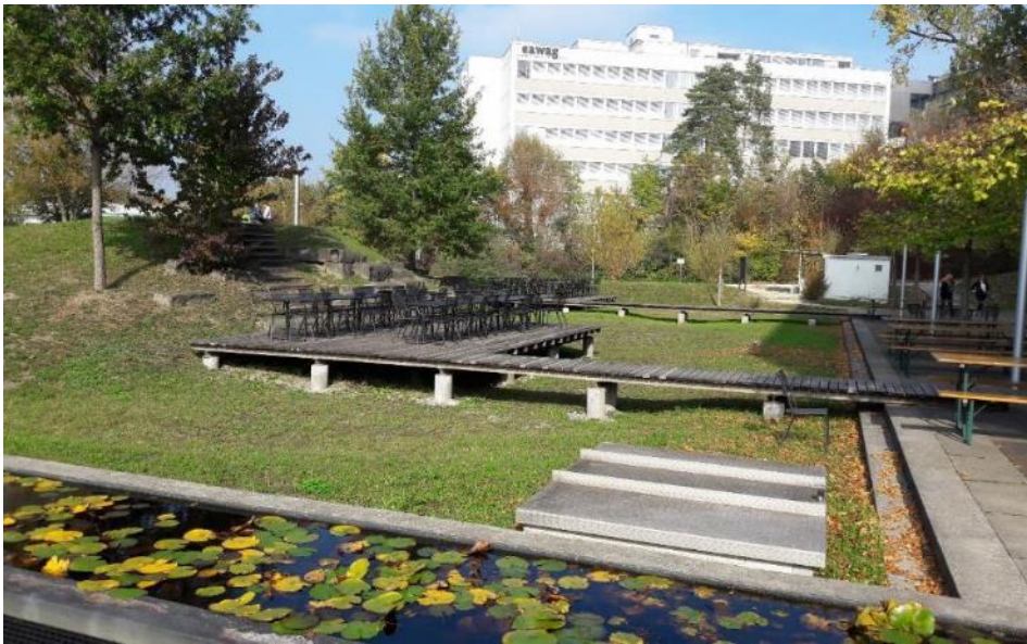
Figur 25. Exempel där delar av gårdsytorna är nedsänkta för att möjliggöra fördröjning och rening av dagvatten. Foto:WRS.
