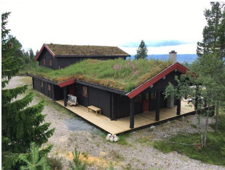
Figur 19. Exempel på utformning av tjockt grönt tak. Foto: WRS.
