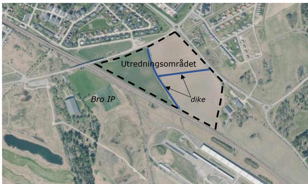
Figur 5-12: Ortofoto utvisande ungefärligt område för planförslaget samt de diken som omfattas av biotopskydd. Källa: Utredning om exploatering av jordbruksmark, AFRY, 2020.
