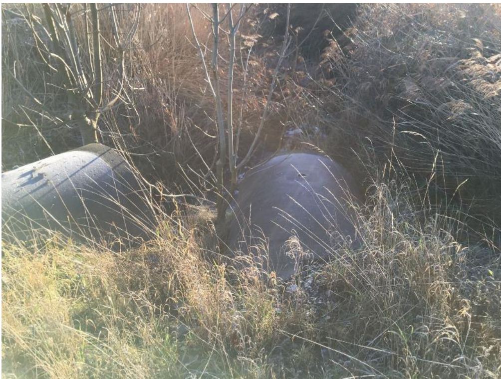
Figur 4. Bilden visar inloppet till krandiket som passerar genom planområdet. Fotot är taget från Ginnlögs väg söderut. I bild ses trumman som passerar under Ginnlögs väg från den lilla dikessnutten norr om vägen samt utloppet dagvattenledning från del av det tekniska avrinningsområdet. Trummorna är av samma dimension med en innerdiameter på 1000 mm.
