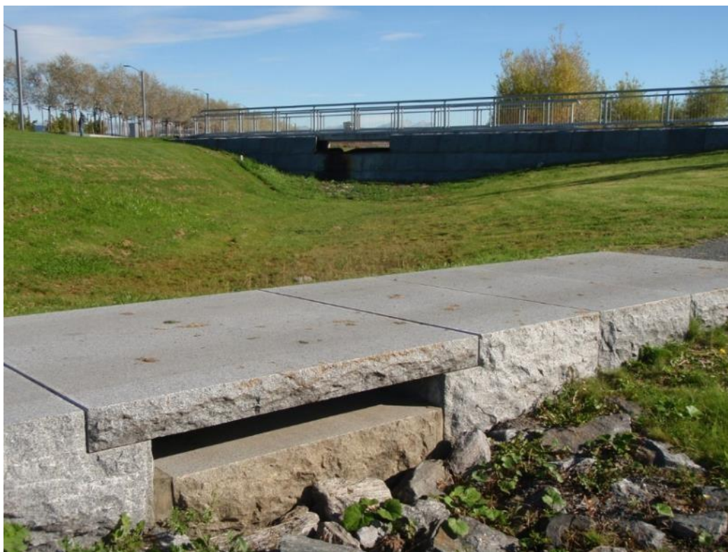
Figur 30. Exempel på utformning av hålldammar (en typ av torra dammar). Foto: WRS.
