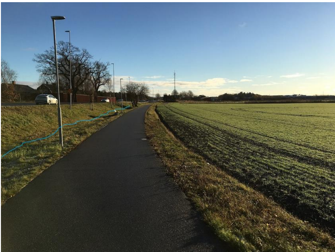
Figur 7. Bilden visar diket längs Enköpingsvägen. Foto: WRS (2020-11-27).
