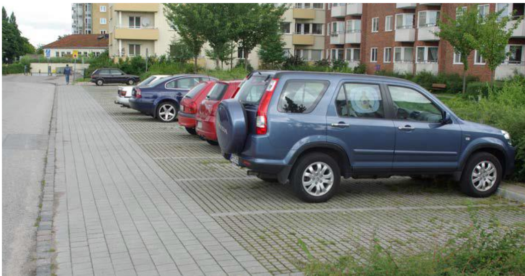
Figur 22. Exempel på parkering med genomsläpplig beläggning. Foto WRS.
