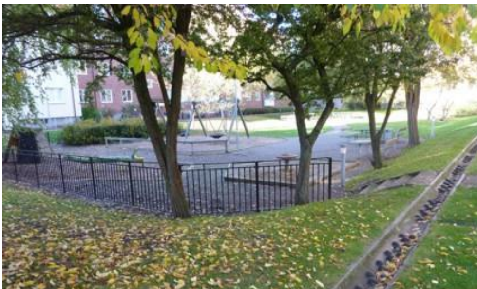
Figur 18. Exempel på utformning av rännor för avledning av takdagvatten. Observera att utformningen med stenar i rännan inte är rekommenderat ur skötselsynpunkt, utan släta ytor är att föredra. Foto: WRS.
