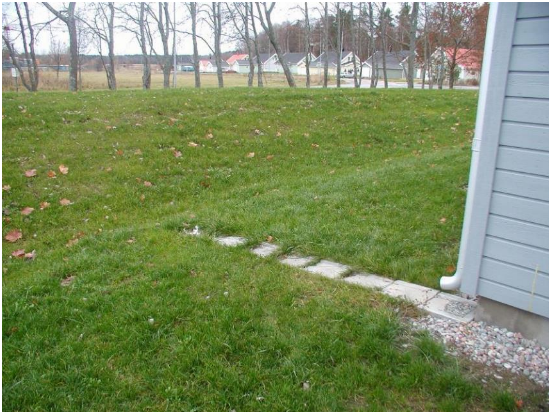
Figur 26. Exempel på hantering av takdagvatten genom infiltration i grönyta samt ytlig avledning mot svackdike/infiltrationsstråk. Foto: WRS.
