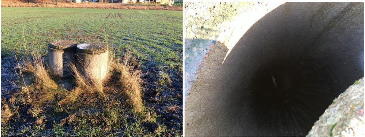
Figur 10. Brunn på lokal ledning som tar emot vatten från brandstationen. Foto: WRS (2020-11-27).
