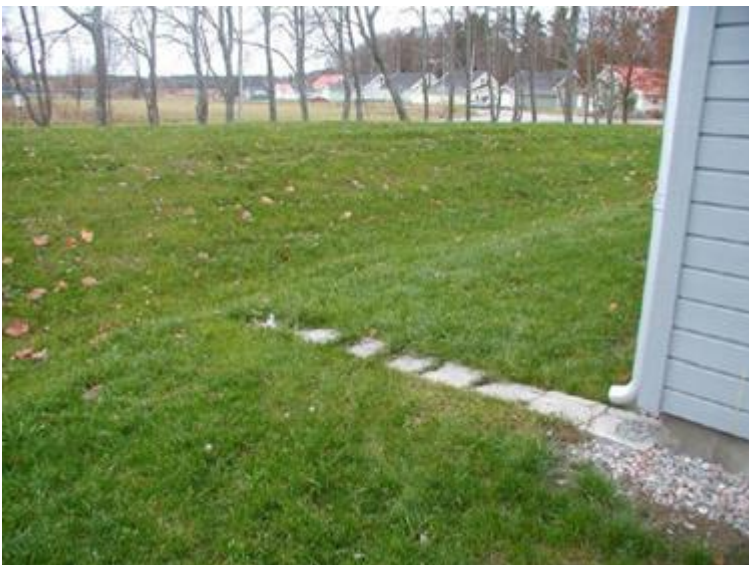
Exempel på hantering av takdagvatten genom infiltration i grönyta samt yttlig avledning mot svackdike/infiltrationsstråk. Fotot: WRS
