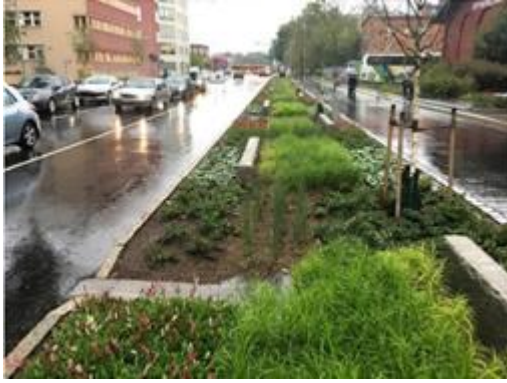
Till vänster exempel på utformning av nedsänkta växtbäddar med trädplantering i anslutning till gata, gång- och cykelväg och parkering. Foto: WRS
