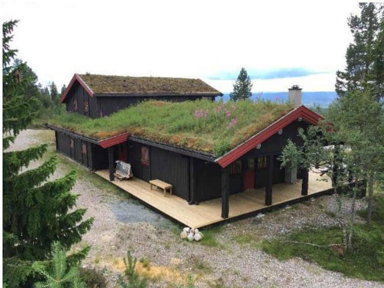
Figur 14. Exempel på utformning av tjockt grönt tak. Foto: WRS.
