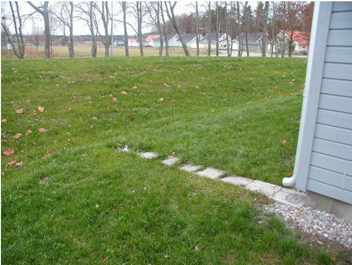
Figur 26. Exempel på hantering av tahdagvatten genom infiltration i grönyta samt yttlig avledning mot svackdike/infiltrationsstråk. Foto: WRS.
