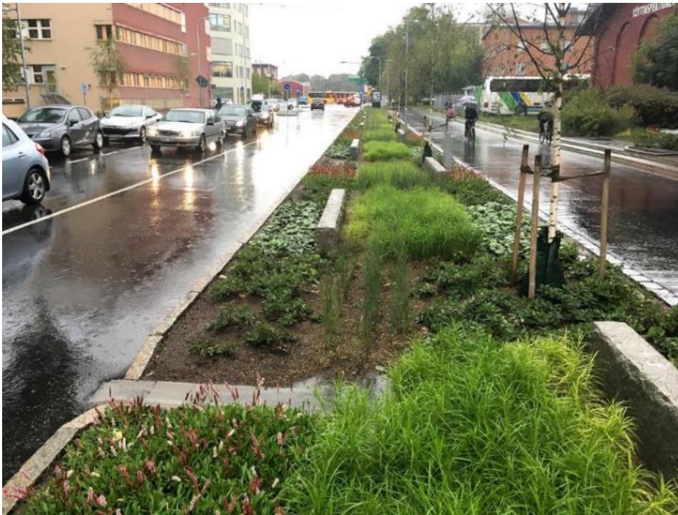
Figur 21. Exempel på utformning av nedsänkta växtbäddar med trädplantering i anslutning till gata, gc-väg och parkering, Uppsala. Foto: WRS.
