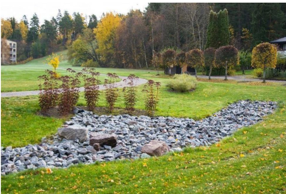
Figur 32. Exempel på utformning av yta som används för utjämning och viss rening av dagvatten vid större nederbördsevent, Täby. Foto: WRS.
