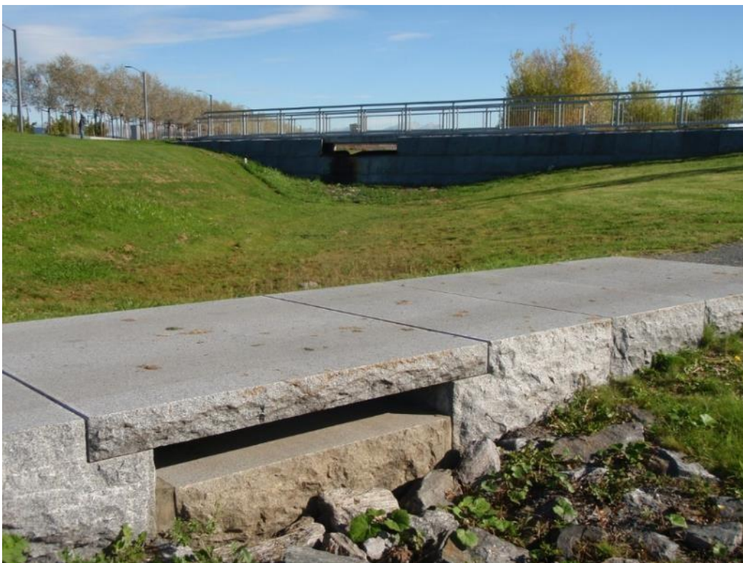
Figur 31. Exempel på utformning av hålldammar (en typ av torra dammar). Foto: WRS.
