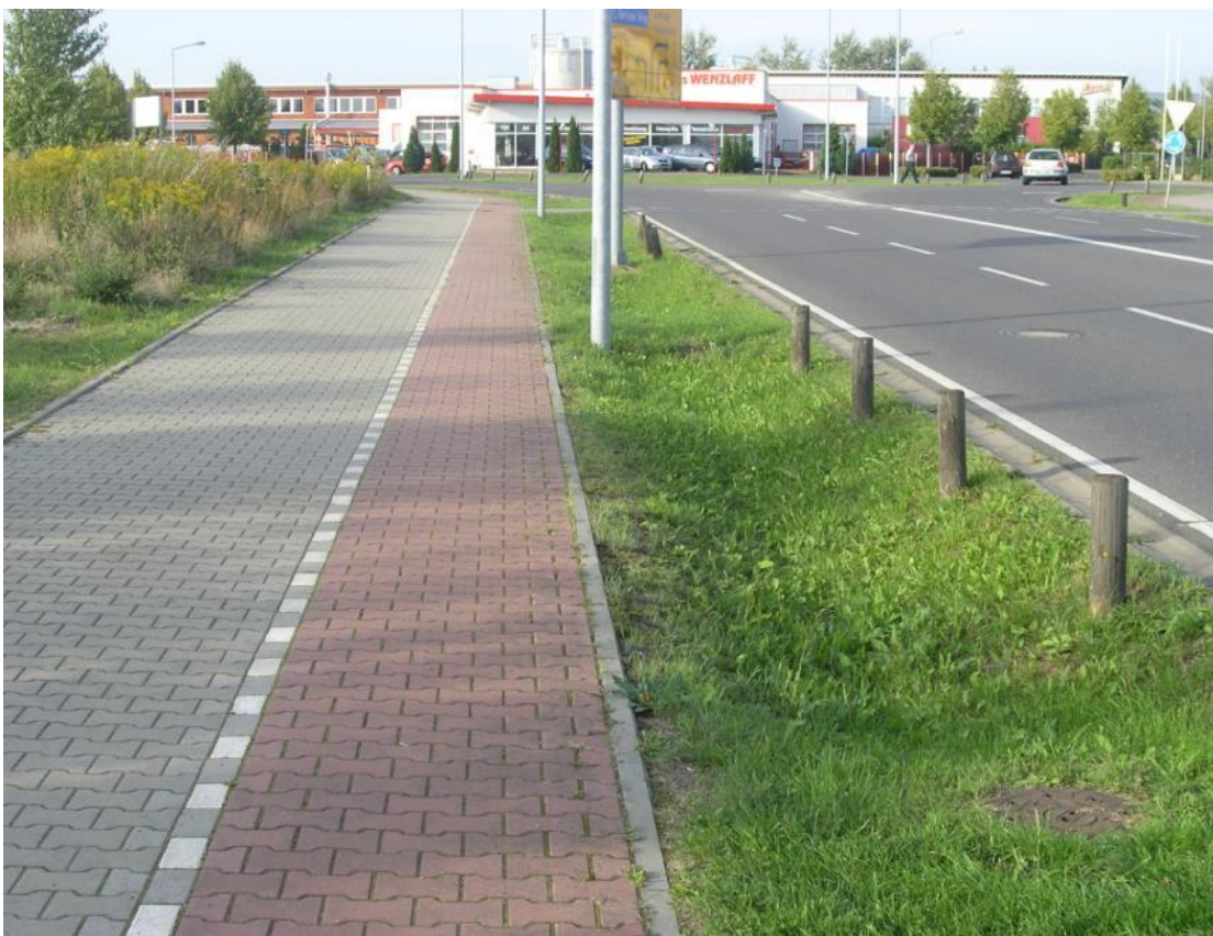
Figur 27. Exempel på infiltrationsstråk som tar emot vatten från en gång- och cykelväg samt från gata (via öppen ränna och brunnar) i Berlin. Foto: WRS.
