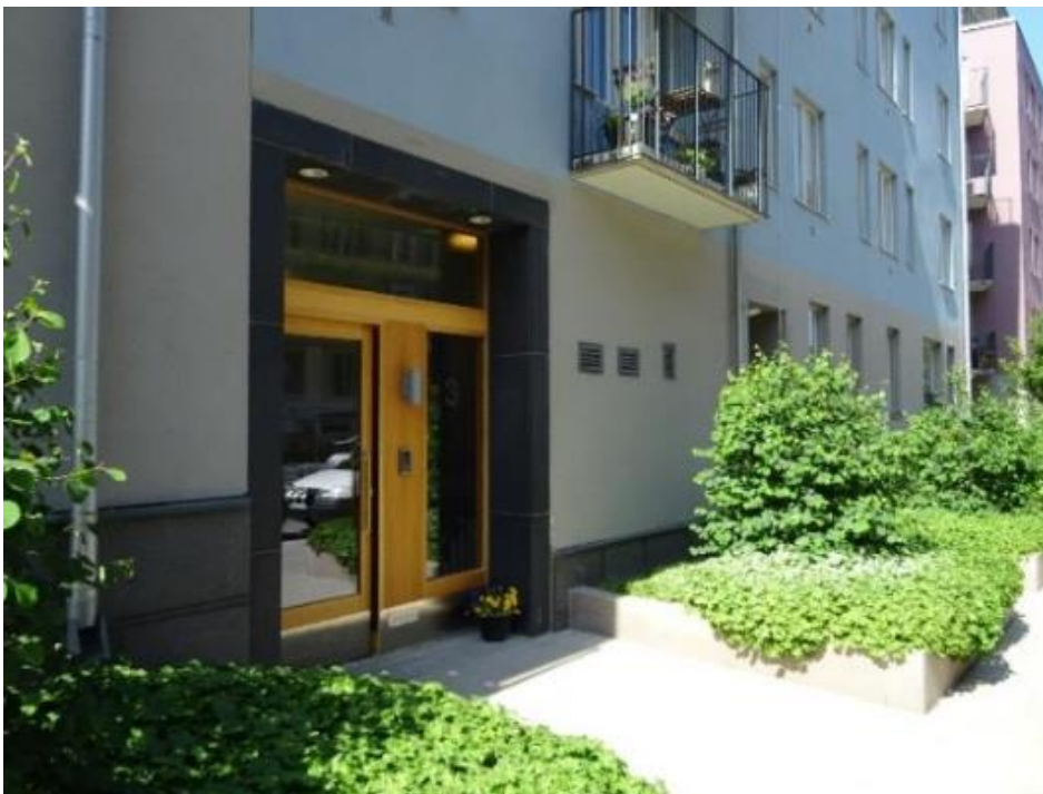
Figur 16. Exempel på regnbäddar för takvatten typ förgårdsmark, Stockholm. Foto: WRS.
