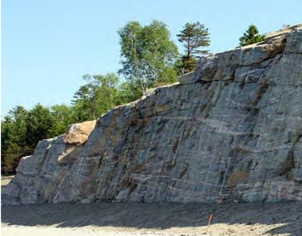
Figur 6.3 Planförslaget är anpassat efter topografin genom att vissa höjder och skogsområden bevaras men sprängning kommer att ske, vilket påverkar landskapsbilden. Bergskärningar bör utföras med skonsam sprängning och påverkan på omgivande natur behöver beaktas.
