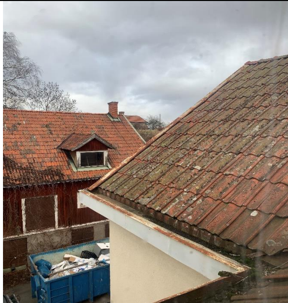
Bild 5: Fasad Nord/Ost :Hängrännor samt vindskivebeslag rostangripna, rännor ej rensade Åtgärder bör ske inom närmsta året
