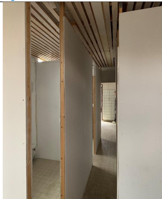
Bild 16: Plan 1: innerväggar uppställda provisoriskt på plan 1 med undertak av glespanel som ej är gipsad eller klädd med annat material.
