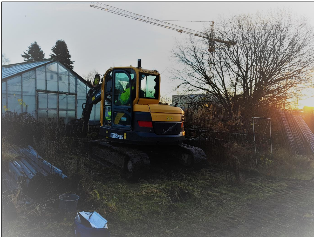
Figur 3. Påbörjad grävning av provgrop PG8 på fastighet Härnevi 1:35 intill växthus.
