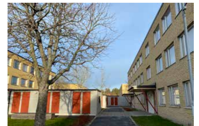
Bostadsområde Råby. (Bild: C F Möller) Kompletteringar som lägger nya lager till historien.
