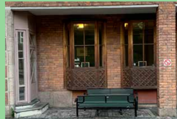
Socialstyrelsen, Västerbroplan (Bild: C F Møller. Arkitekt Kjell Ödeen) Lekfull och värdig detaljering.
