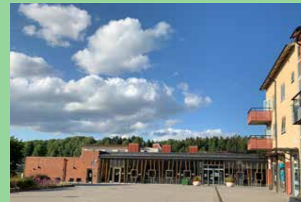
Brohuset (Bild: C F Møller) Fasader på offentlig byggnad som både är vägg i det offentliga rummet, karaktärsskapande objekt och inbjudande övergång mellan ute och inne.
