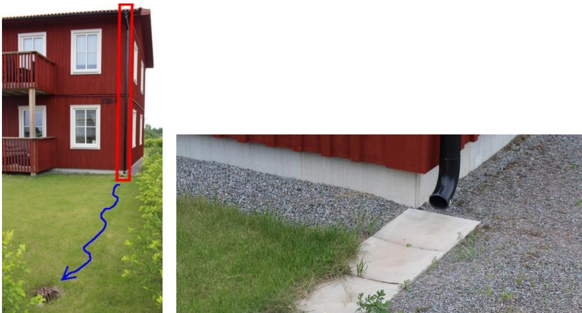
Figur 22. Till vänster: Avledning av takvatten via utvändigt stuprör (inringat i rött) till grön yta. Till höger: Stuprör med utkastare och plattsättning.
