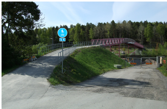
Gång- och cykelbro över järnvägen
