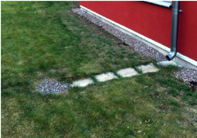
Figur 18. Avledning takvatten för infiltration i grönyta. 23
