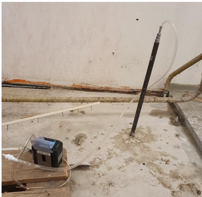
Figur 6. Stålsond och porluft pump installerad vid troliga läget för fd tvättmaskin.
