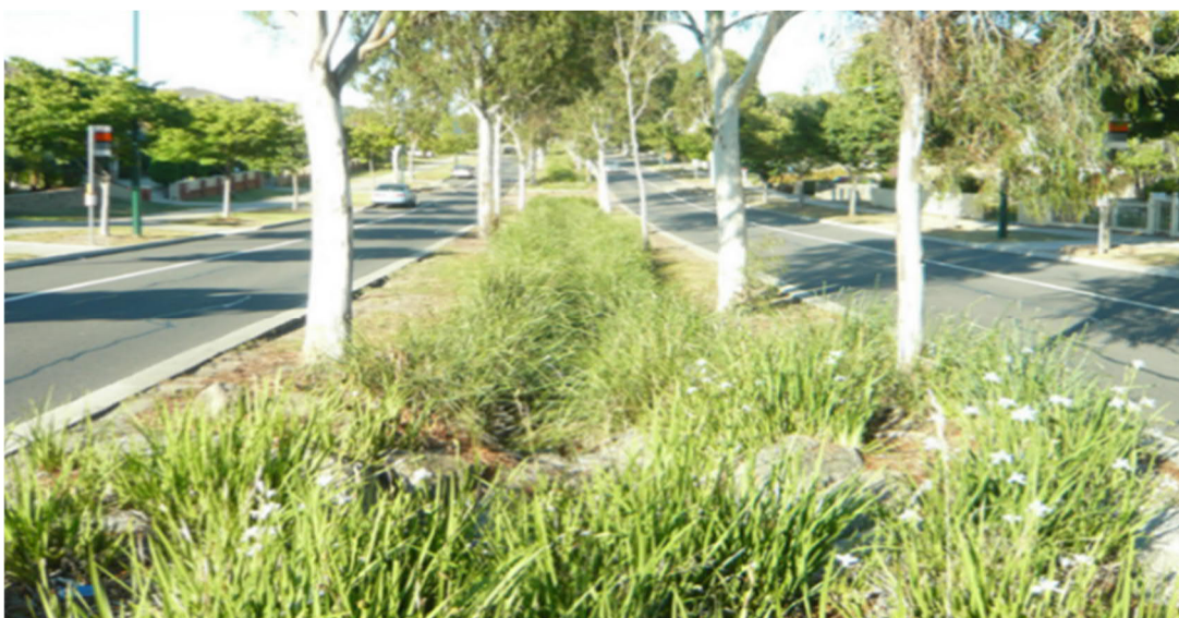
Figur 14. Exempel träd i skelettjord med öppet täcklager av äng och buskage för rening av dagvatten. 23
