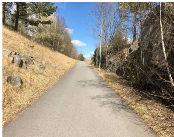
Figur 14 Gång- och cykelstråk längs Granhammarsvägen.
