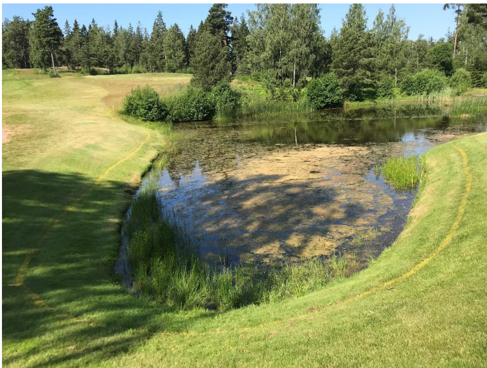
Figur 9. Befintlig damm inom planområdet. Här syns den permanenta vattenytan samt den tillfälliga vattenytan som indikerar reglervolymer.
