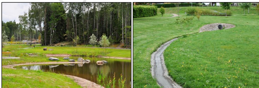
Figur 10. Exempel på dagvattendammar. Till vänster ses en dagvattendamm med permanent vattenspiegel. Till höger ses en torr damm som fylls vid nederbörd.
