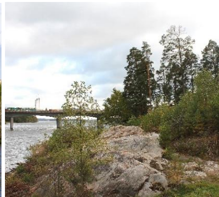
Strandlinjen mot järnvägsbron
