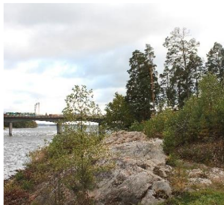
Strandlinjen mot järnvägsbron
