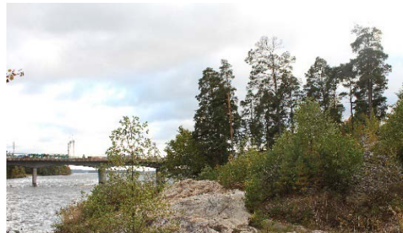
Strandlinjen mot järnvägsbron
