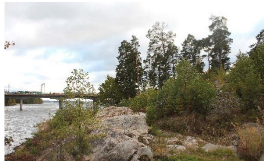
Strandlinjen mot järnvägsbron
