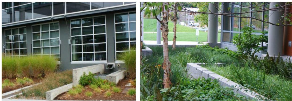
Figur 6. Stuprörsutkastare mot växtbädd med fördröjningszon.
