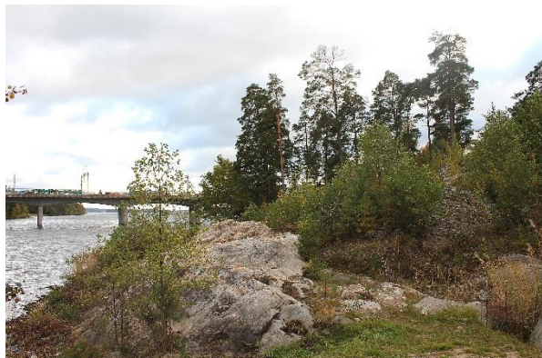
Strandlinjen mot järnvägsbron
