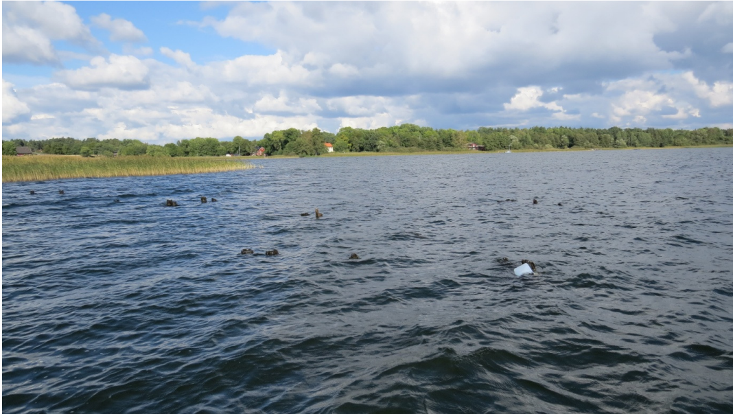
Figur 5. Gamla bryggpålar sticker upp ur vattnet som rester av en stor badbrygga från spetsen av udden, se figur 1. De yttersta pålarna visar att bryggan var bredare där, vid plattformen för hopptornet. Den yttersta västra bryggpålen är markerad med ett vitt flöte.
