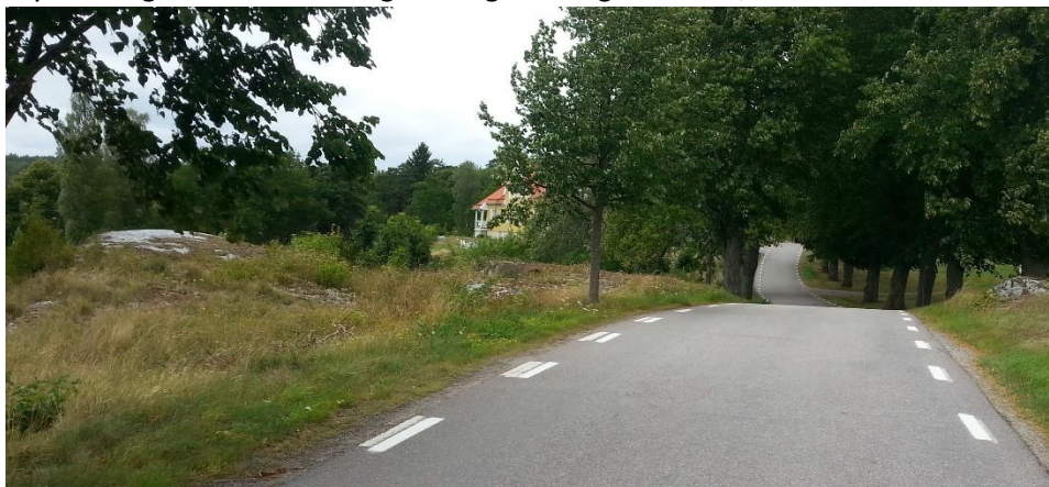
Bild 1. Rösaringsvägen del II är med sin allé Riksintresse
