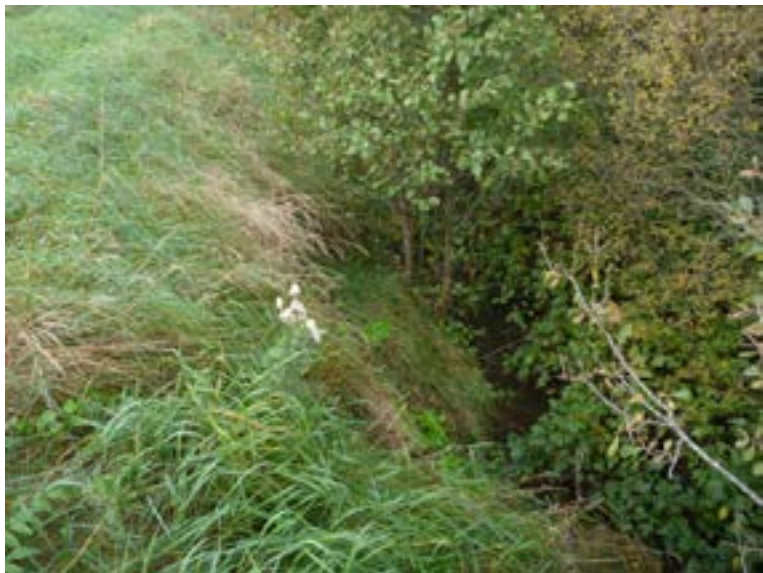
Brant stående slänt som hålls upp av tät vegetation.
