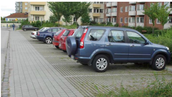
Figur 14. Exempel på genomsläpplig beläggning på parkeringsplats. 15
