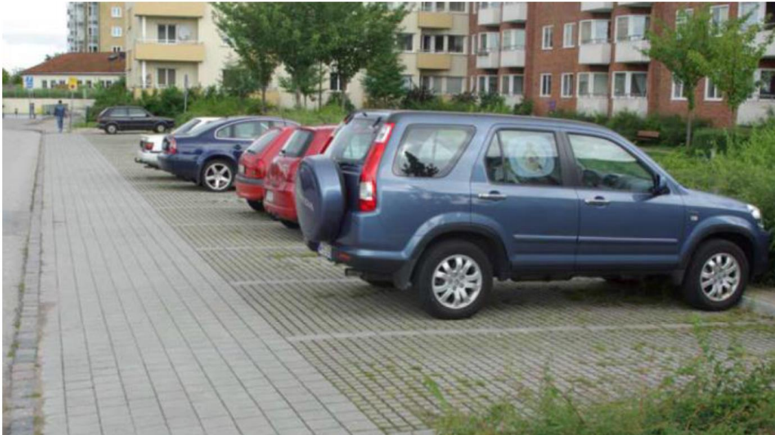
Figur 15. Exempel på rasterbeläggning under bilarna i bilden. Armerat gräs är en annan sorts rasterbeläggning.
