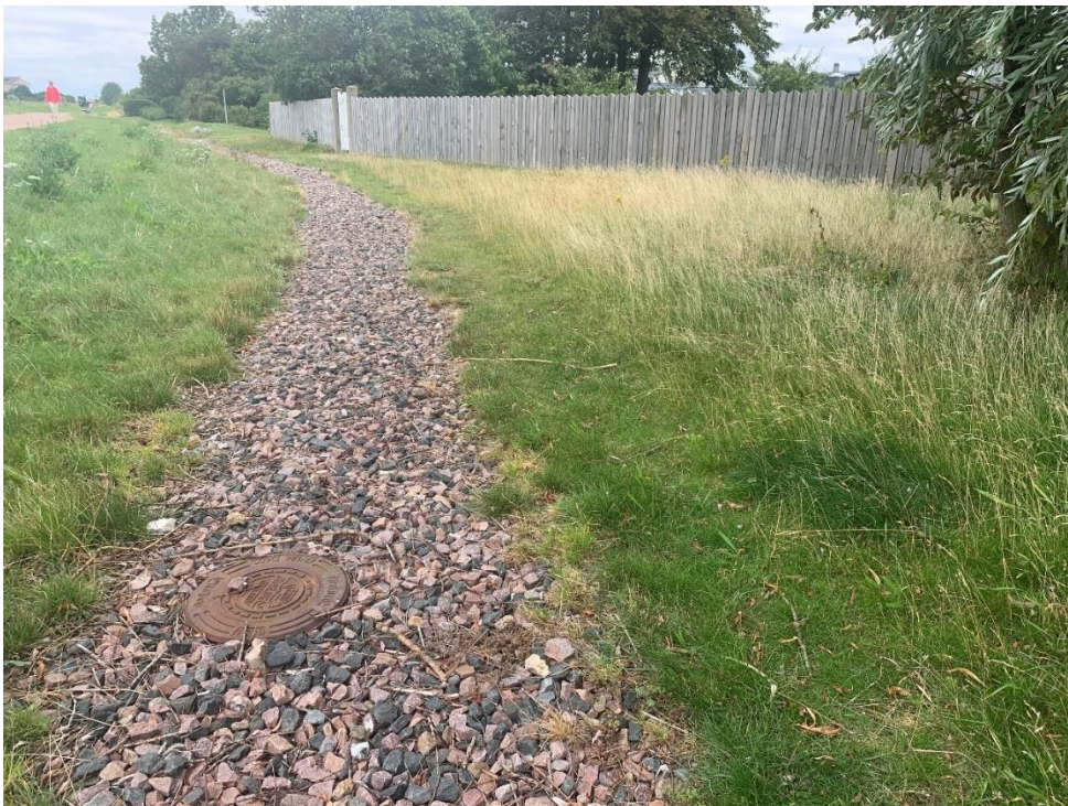
Figur 12. Exempel på öppet krossdike (foto Bjerking).
