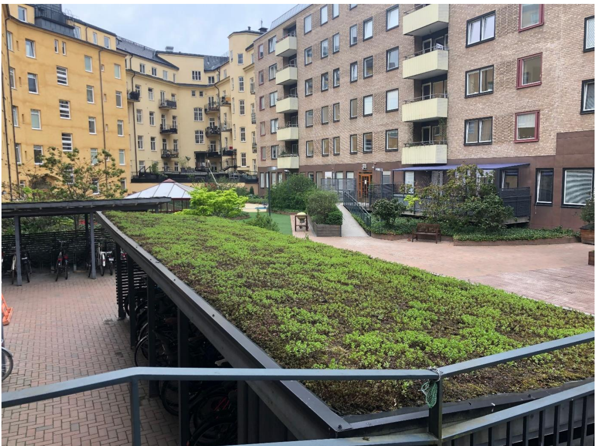
Figur 10. Ett exempel på ett grönt tak över en cykelparkering på Södermalm i Stockholm (Foto Bjerking).
