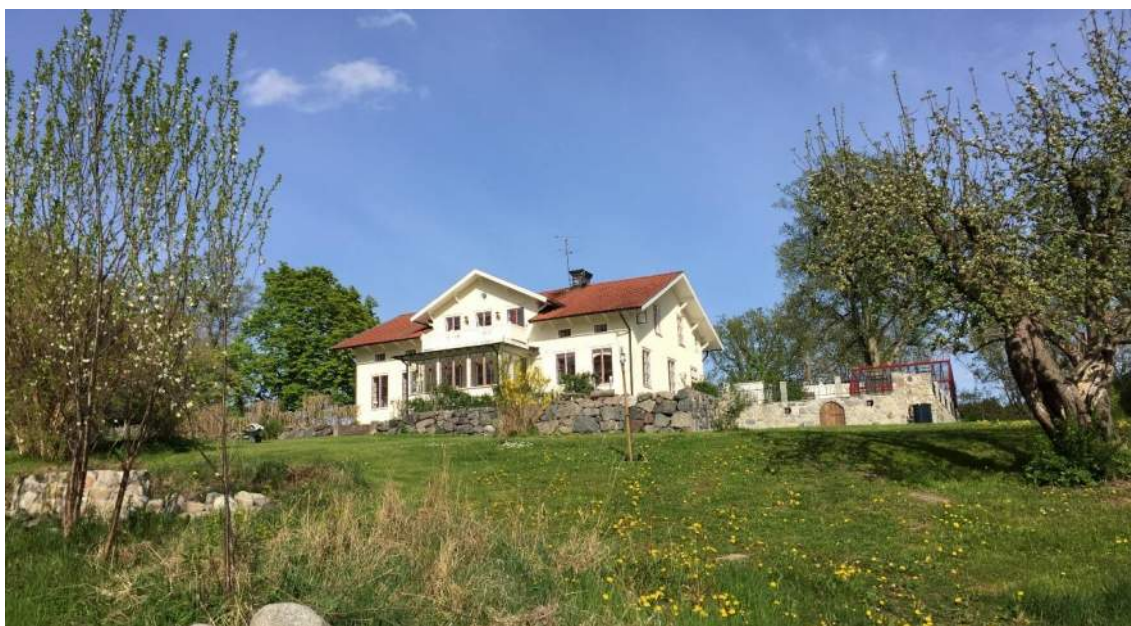
Ekhammars gårds huvudbyggnad sedd från gång- och cykelväg sydväst om gården.
