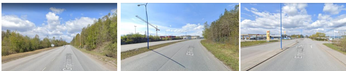
Befintlig utformning av Granhammarsvägen (till vänster) Effektvägen (mitten) och Energivägen (till höger)
