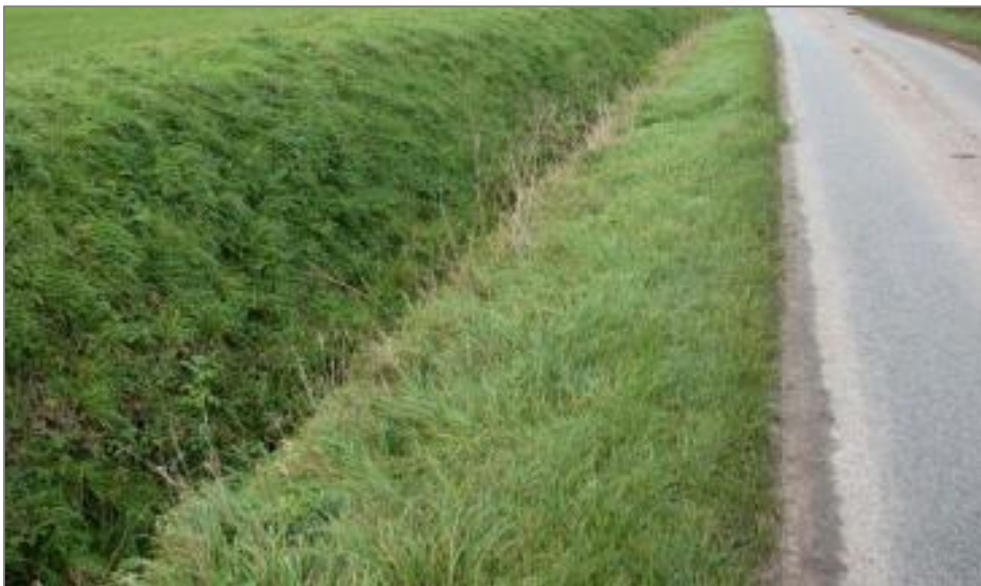
Figur 6-1 Exempelbild av ett gräsdike vid en väggkant.
