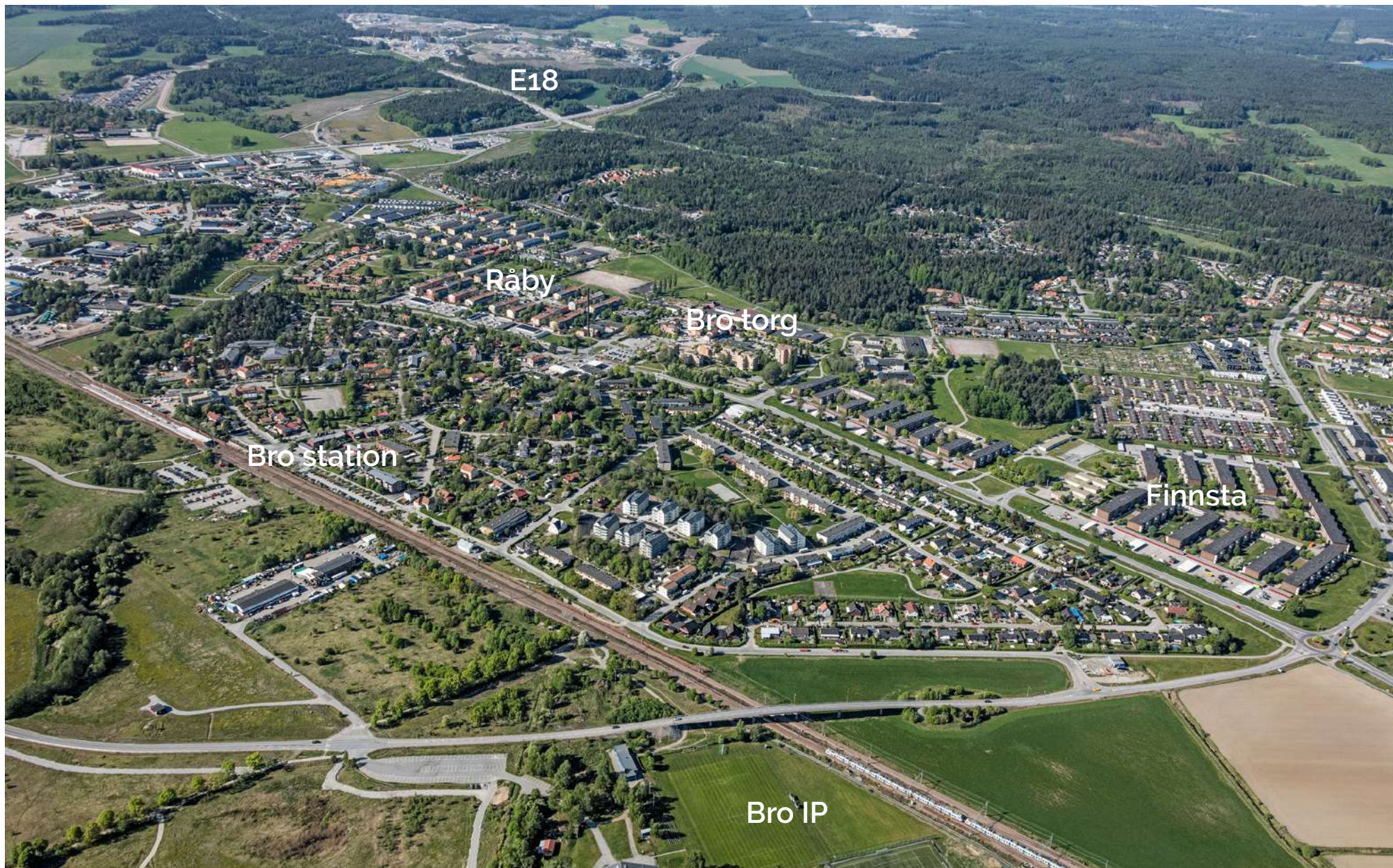
Bro sett från sydost.
