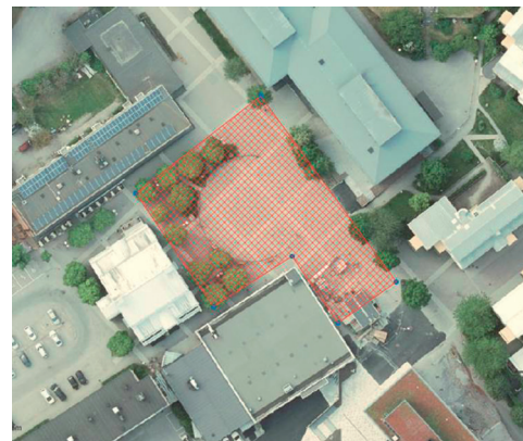
Den rödmarkerade torgytan i Kungsängens centrum ska renoveras under nästa år.
